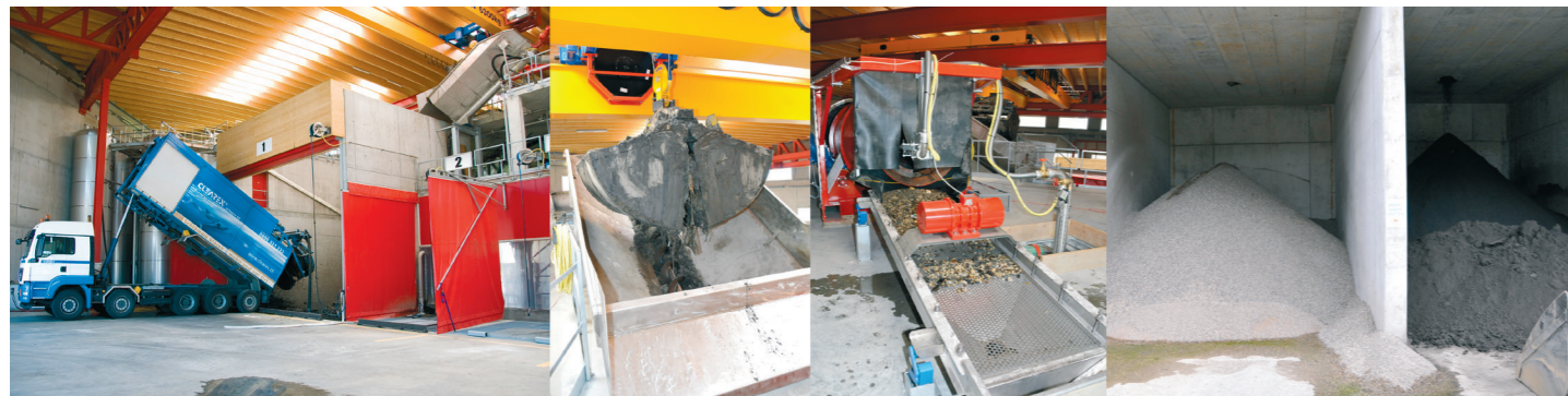
5 Abladegruben sorgen für ein rasches Entladen.
